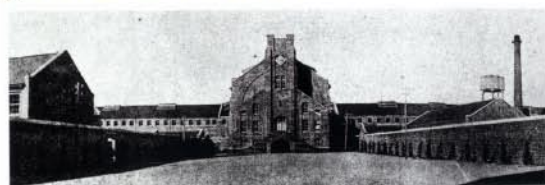
●中央は管理棟 奥に監舎が見える
